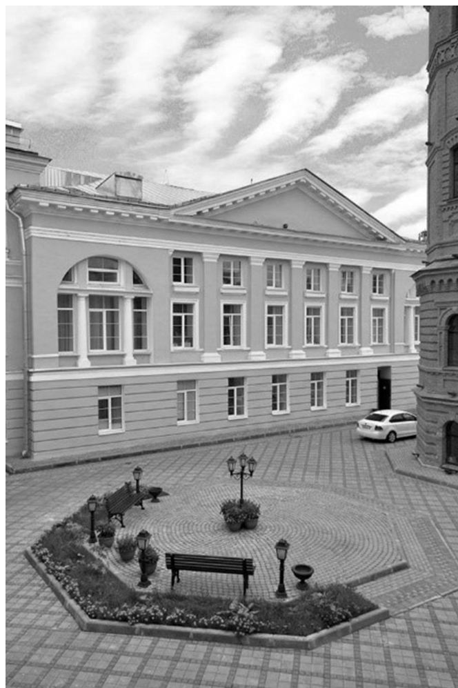
Рис. 5. Современный вид здания бывшего Главного врачебного училища (Инструментальная ул., 3 литера «К»)
